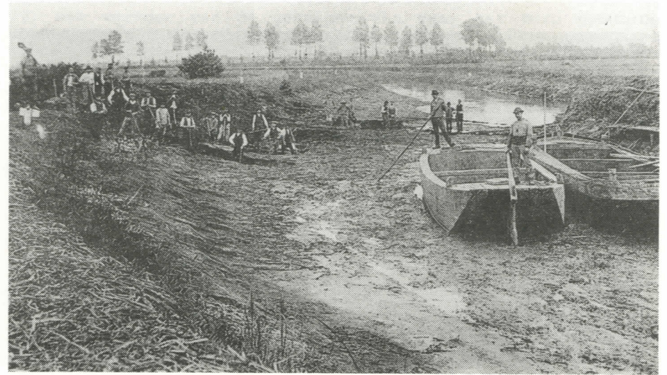
Bouw van het echte sas op Emblems grondgebied. Eén van de grootste werken die men in de vorige eeuw - in 1843 om nauwkeurig te zijn - in onze streken heeft uitgevoerd en bedoeld was om de Kleine Nete te kanaliseren. Op deze foto tellen wij ongeveer 30 man die dagelijks vele uren lang tegen een honderloon moesten zwoegen. Nu knapt men een dergelijk werkje op in een minimum van tijd met één enkele kraan en een paar mensen. (Zie artikel 'Per fiets naar saske 3' in Salvator nr.35/1980)
